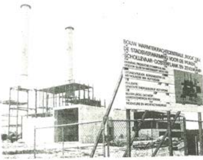
De nieuwe centrale op 3 Spoorwilde in aanbouw
